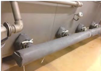
食品製造工程 蒸気配管カバー（外装材：フッ素樹脂含浸ガラスクロス）
