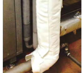
食品製造工程 配管
